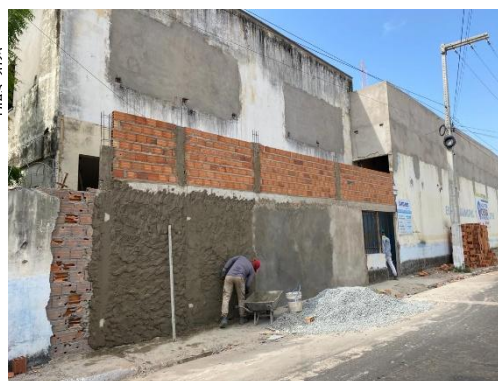
Imagem 31: Pedreiro construindo - São Inês/MA, 2025.
