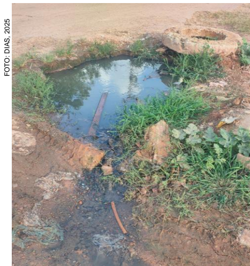
Imagem 14: Bueiro na "Rua E" Sol Nascente - Santa Inês/MA, 2025.
